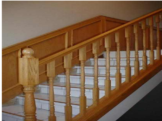
그림 35 계단 디딤코 설치 상태 예
