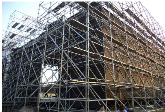
그림 4 부분 조립식 구조물의 설치 현장
