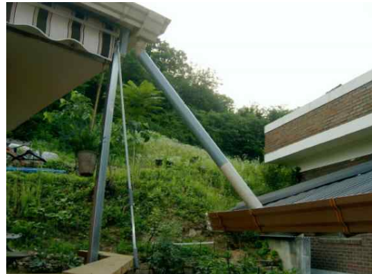
그림 27 우수관 설치 예
