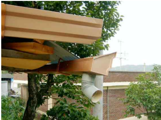
그림 26 우수관 설치 예
