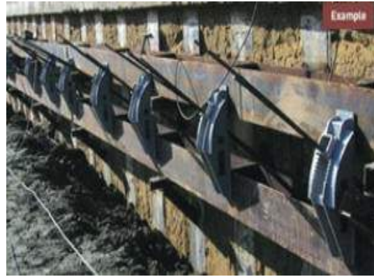
그림 19 앵커 고정 상태 예
