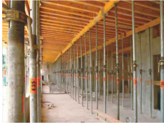
그림 49 버팀목 설치 예
