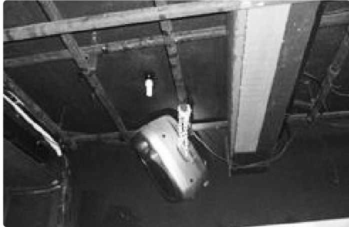
[그림 17] 파이프 그리드에 설치된 스피커(양호)
