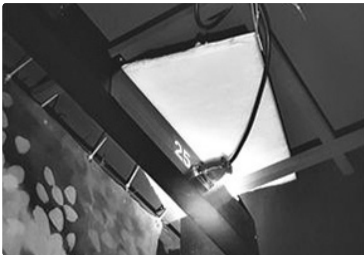
조명덕트에 접속기 접속 상태 확인(양호)
