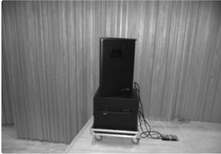
스피커 설치 상태 확인(추락하지 않도록 고정되어야 한다)
