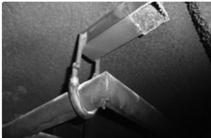
[그림 58] 하중을 버티는 고정점이 용접으로 되어있다면 더 면밀히 관찰하는 것이 바람직하다
