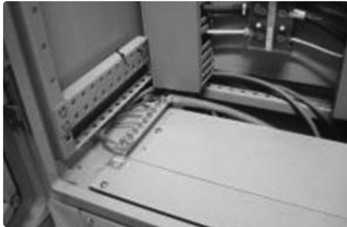
[그림 3] PANEL 외함접지 상태
