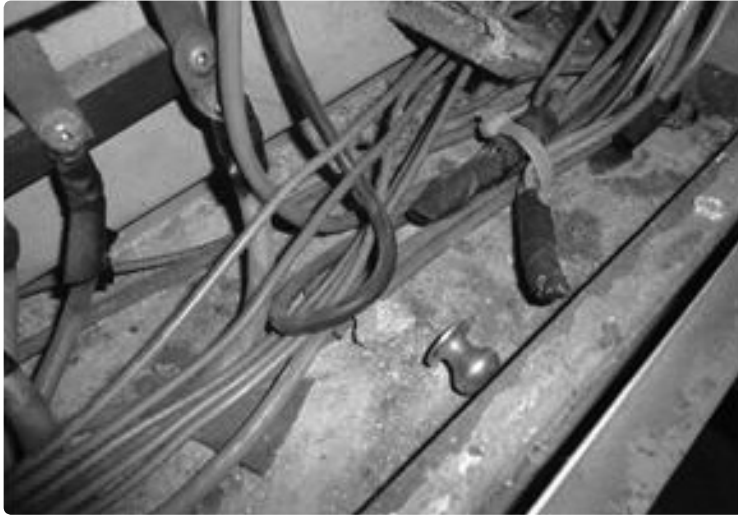
배전반 내부 먼지 쌓임, 습기로 인한 산화 발생(불량)
