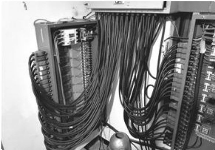
조명 디머 내부 설치상태 확인
