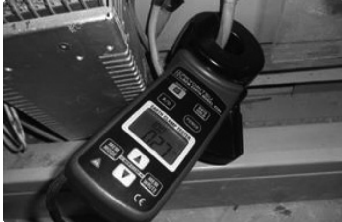
[그림 2] 소규모 공연장 접지 측정
