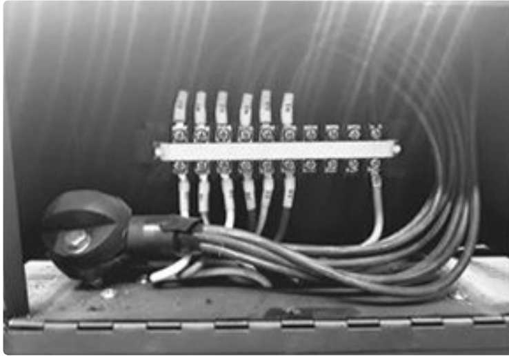
조명 덕트 분전반 안전성 확인(단자대 보호 덮개 없음. 미흡)
