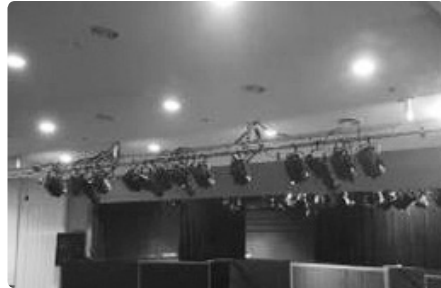
[그림 12] 장치봉에 설치된 조명시설
