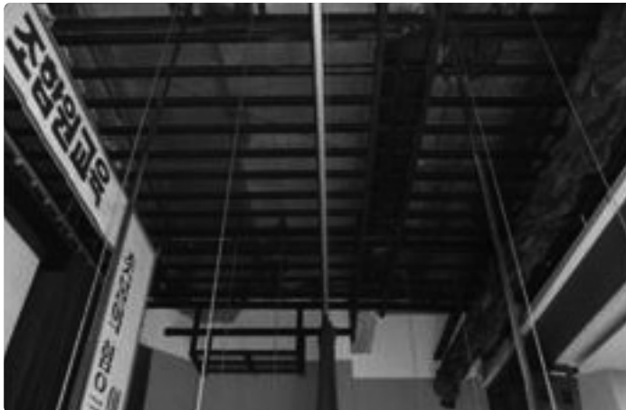
[그림 52] 상부그리드 설치 상태
