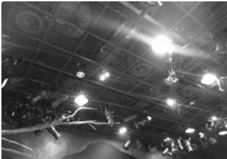
파이프그리드 설치상태 및 조명기 설치 상태 확인
