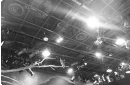
[그림 11] 파이프 그리드에 설치된 조명시설
