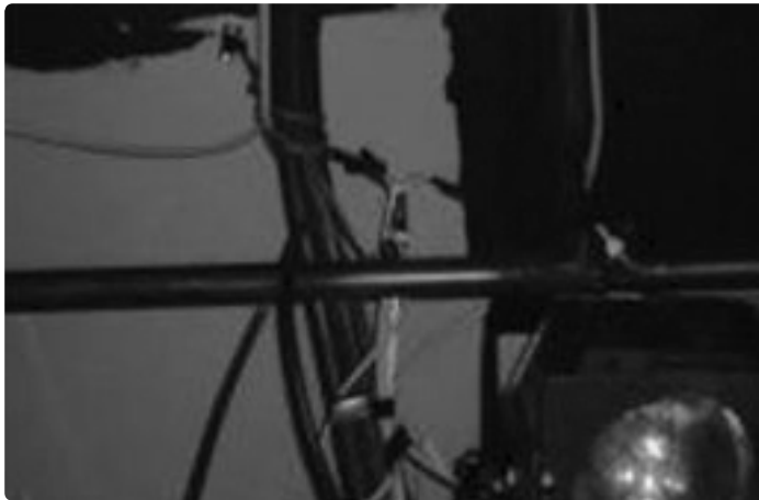
[그림 47] 노출된 전선은 합선 및 손상이 없도록 보호 및 주의
