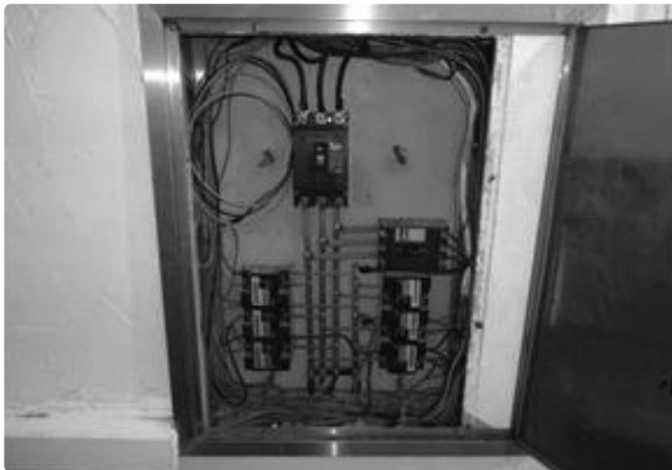
배전반 내부 습기로 인한 전식 발생(불량)
