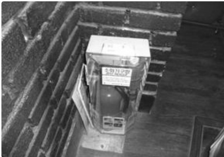
소화기 배치 적정성 및 제작년도, 내부 압력 확인
