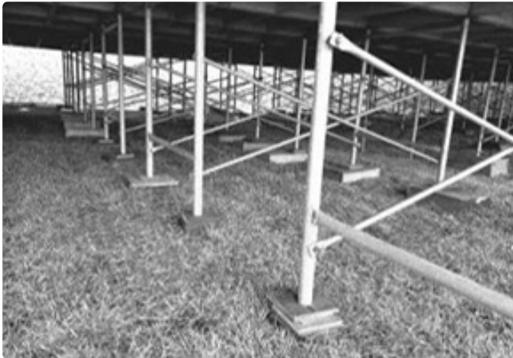
무대 바닥 깔목의 설치
