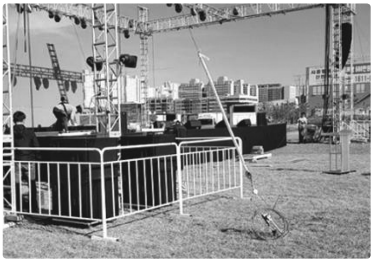
말뚝 + 와이어로프를 이용한 전도방지 ※해당 방식 사용 시 말뚝이 지면에 견고하게 고정되었는지 확인하여야 한다.
