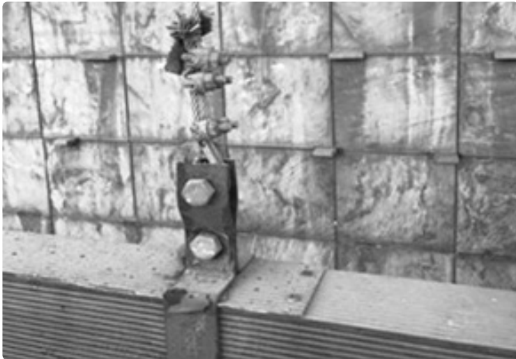
야외무대의 플라이덕트 고정밴드 산화 발생 / 교체 및 보수요망
