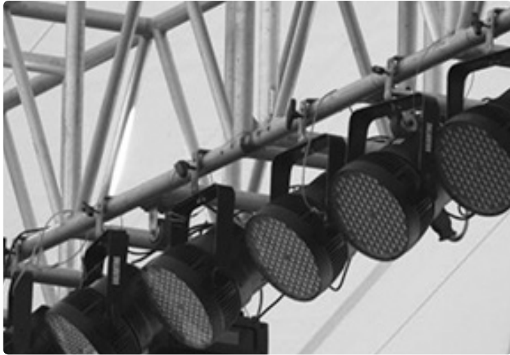
조명기에 추락방지를 위하여 안전고리 설치
