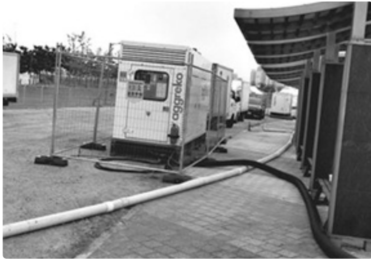
전선관이 개구부 없이 설치됨(양호)
