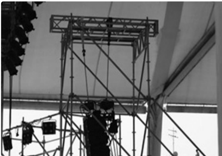
호이스트와 벨트 슬링 이용한 스피커 매달기
