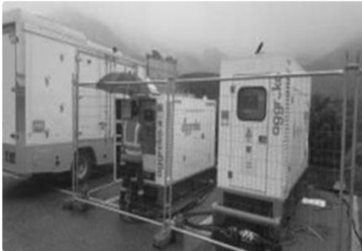
전기설비의 독립적 설치 및 펜스로 보호/양호
