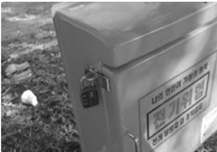
분전반 외함에 잠금장치 설치
