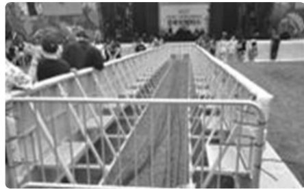
무대 앞 전도방지 펜스 설치
