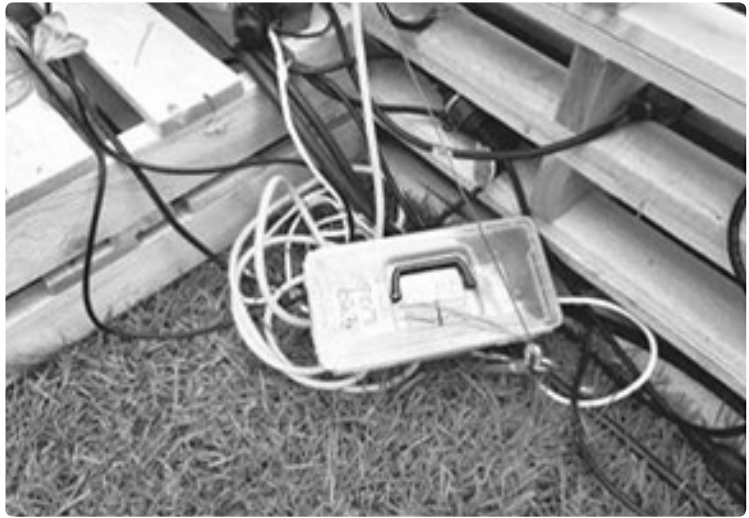
접속부의 방수조치 / 미끄, 임시조치임. 방수타입 접속부 사용할 것
