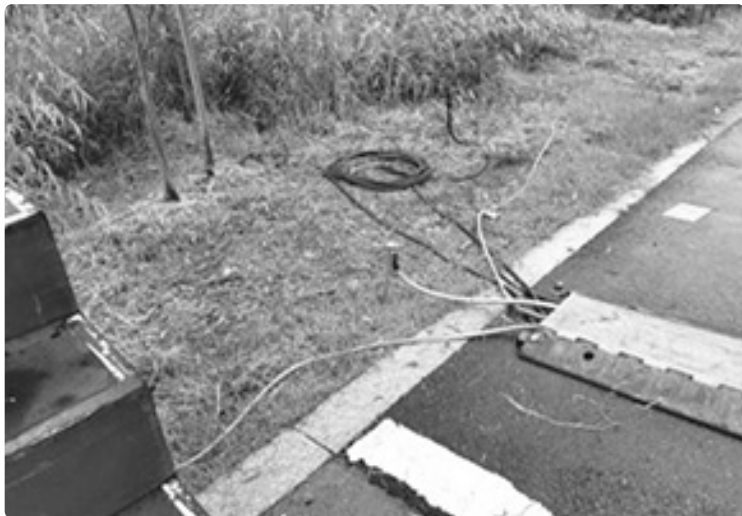
분전반의 설치상태 / 불량, 주변에 가연물 없이 정리할 것
