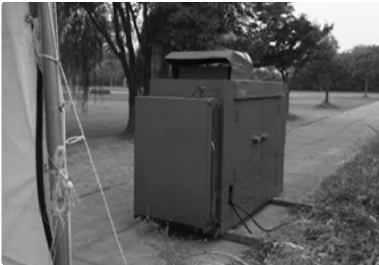
불량 예 : 발전시설 격리되어있지 않으며 관리자 미상주
