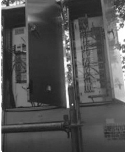
공원에 기 설치 된 배전함(방수형)
