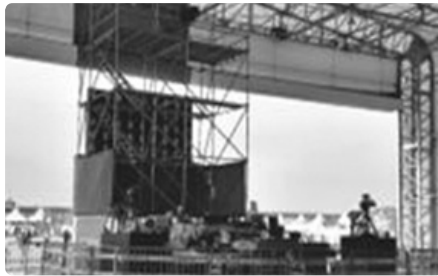
조명·음향설비에 펜스 설치
