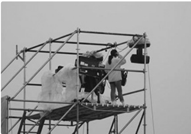
카메라 타워 위 안전장비 미착용으로 엔지니어의 추락위험/불량
