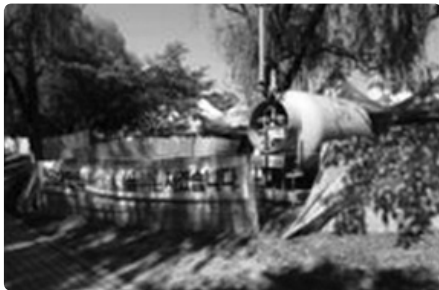
울타리를 이용한 가스설비 접근 통제
