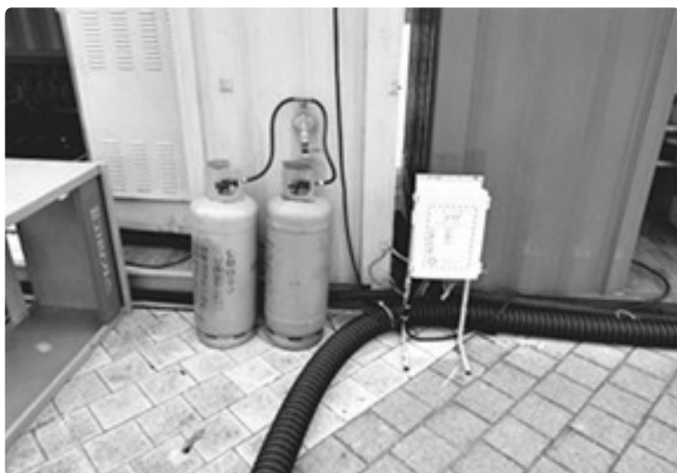
전선관이 개구부 없이 설치됨(양호)
