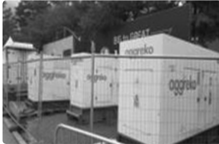
펜스를 이용한 전기설비 접근 통제
