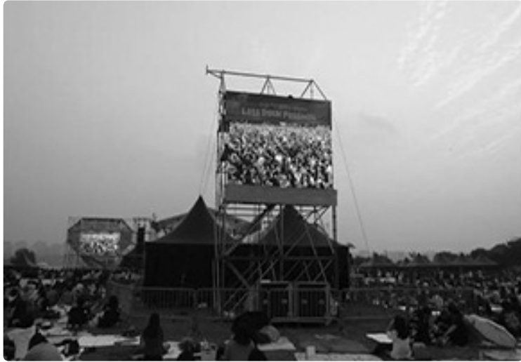
비계를 사용한 스크린의 설치
