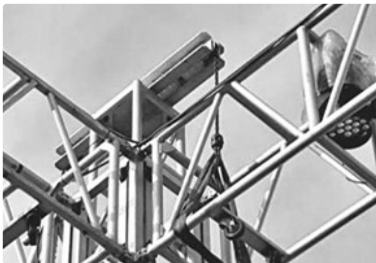
트러스의 높이를 벨트 슬링, 체인, 도르래를 사용하여 이동 및 고정
