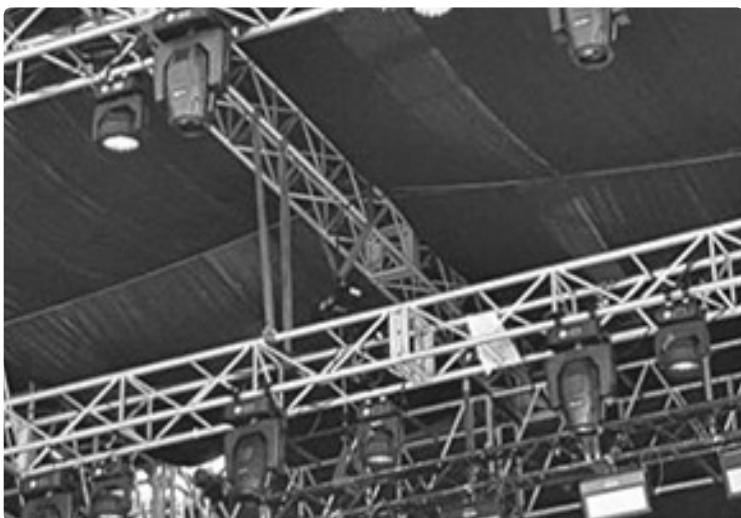
벨트 슬링 이용한 트러스의 매달기
