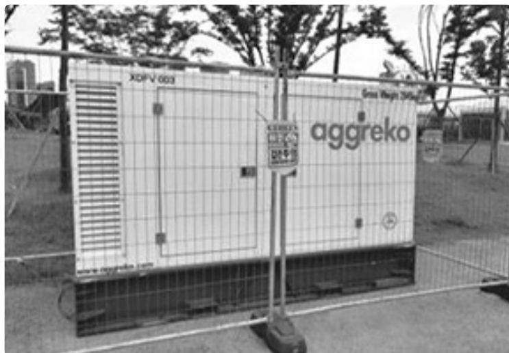
양호 예 : 발전시설이 격리되어 있으며 배선상태 양호함, 소화기 비치됨
