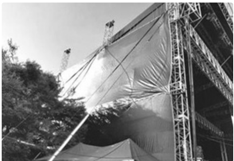
와이어로프 및 말뚝을 이용한 가설무대의 전도 방지
