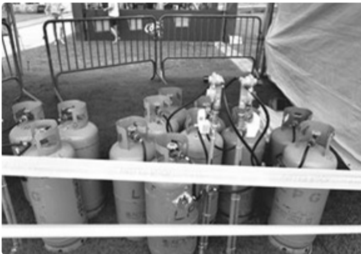
가스시설의 설치상태 - 통제되고 있으며 보호되어 있음 : 양호
