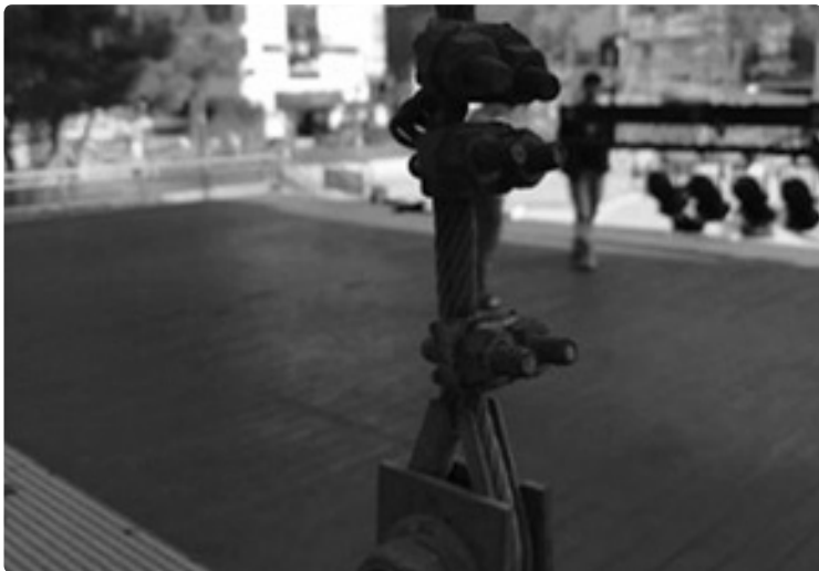
야외무대의 와이어로프 체결부 산화 발생 / 교체 및 보수요망
