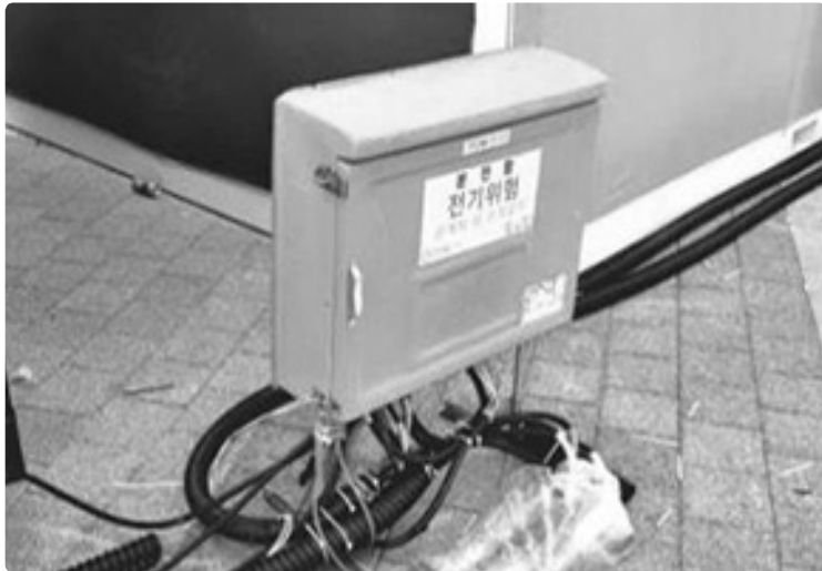
분전반의 설치/불량, 잠금장치 없음
