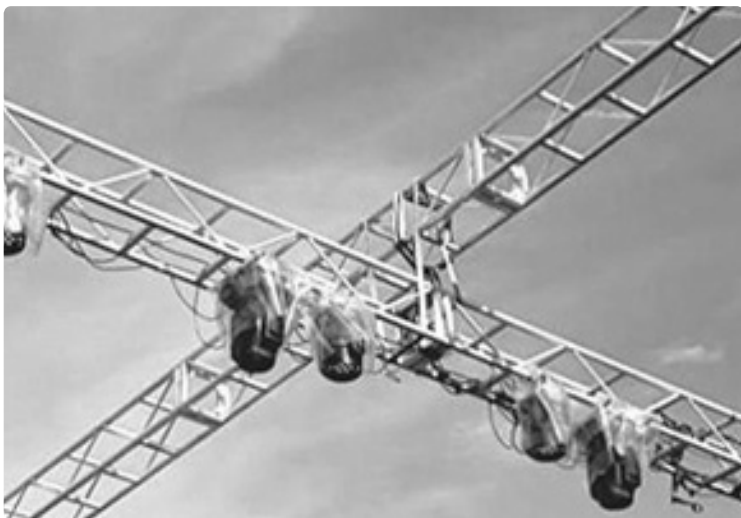
벨트 슬링 이용한 트러스의 매달기
