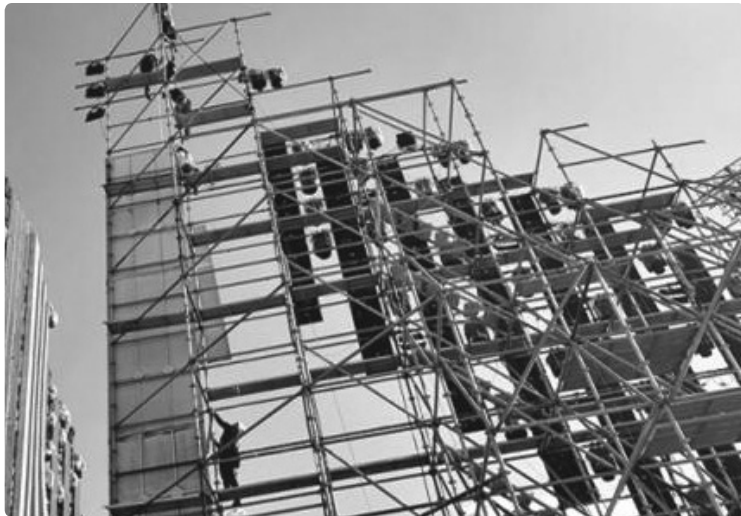
비계 가설구조물 내 비계발판의 설치
