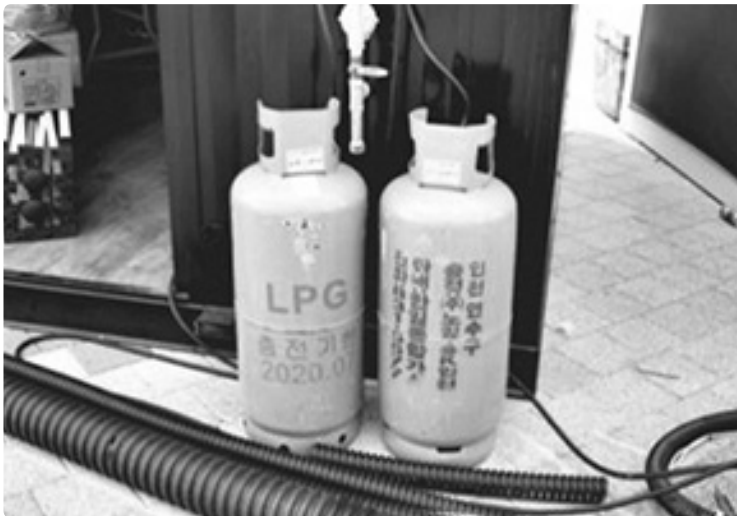
가스시설의 설치상태 - 통제 및 보호되어있지 않음 : 불량
