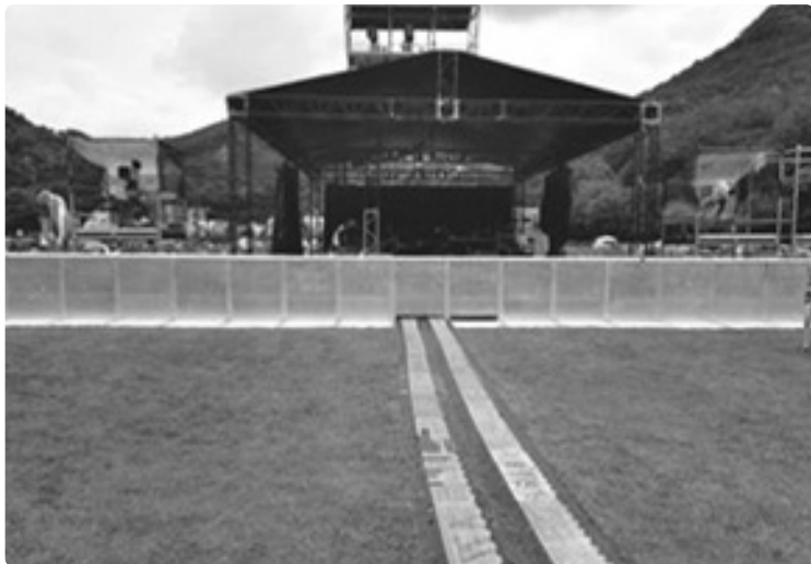
전선보호덮개의 설치 / 양호
