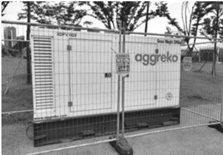
전기설비의 독립적 설치 및 펜스로 보호/양호
